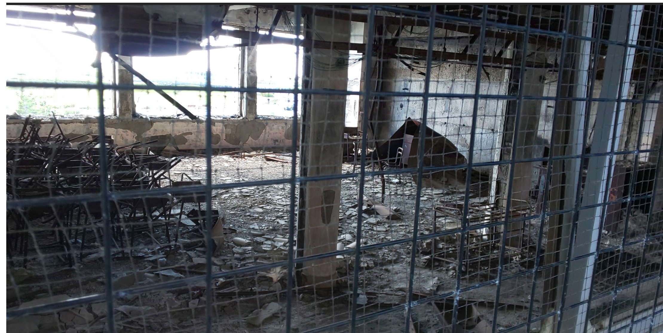
(つづき) 教室内部(震災遺構門脇小学校)
